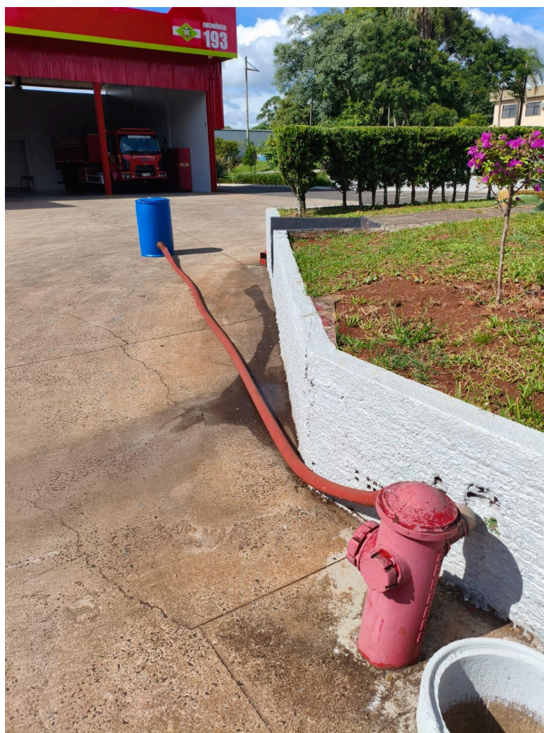
Figura 2 - Montagem do teste (manter a mangueira o mais esticada quanto for possível, para evitar perdas ou erros)
