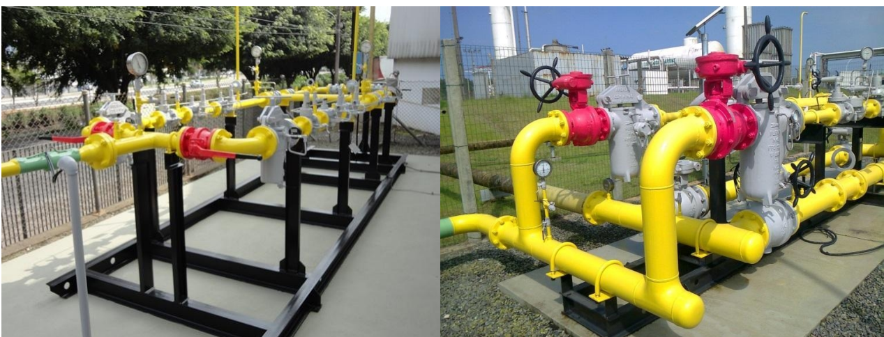
Figura 1: Válvulas de fechamento de gás em edificações.
